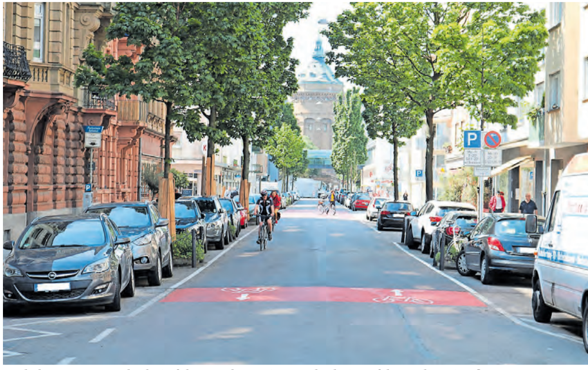
Nach dem ersten Bauabschnitt folgt nun der zweite Bauabschnitt auf der Berliner Straße. FOTO: STADT MANNHEIM
