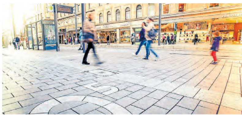
Die neuen Intarsien – große, weiße Buchstaben, die in das neue Pflaster auf den Planken eingelassen wurden – dienen Passanten als Orientierung in den Quadraten.
