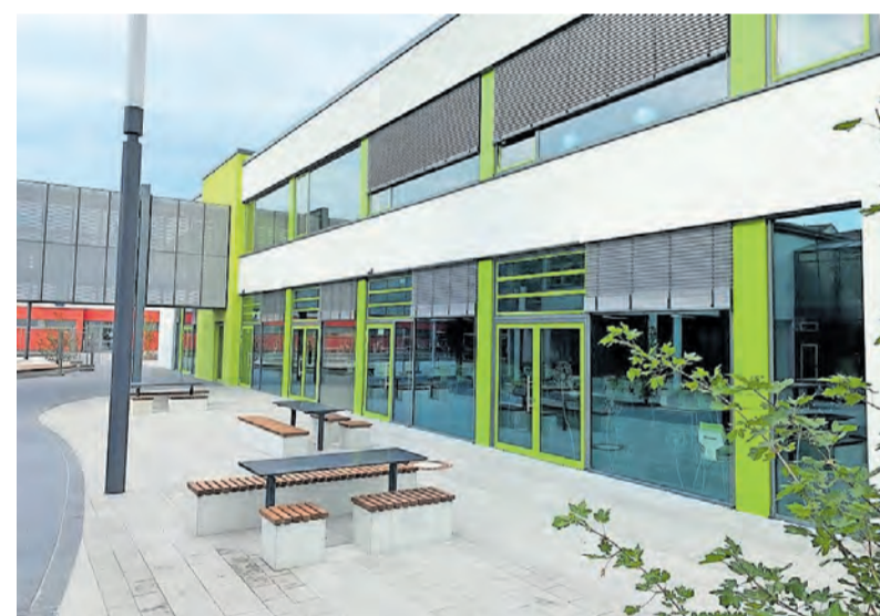
Die Bertha-Hirsch-Schule erhielt mit dem neuen Gebäude für rund 5,6 Millionen Euro eine Mensa, die auch über eine Bühne verfügt. FOTO: STADT MANNHEIM
