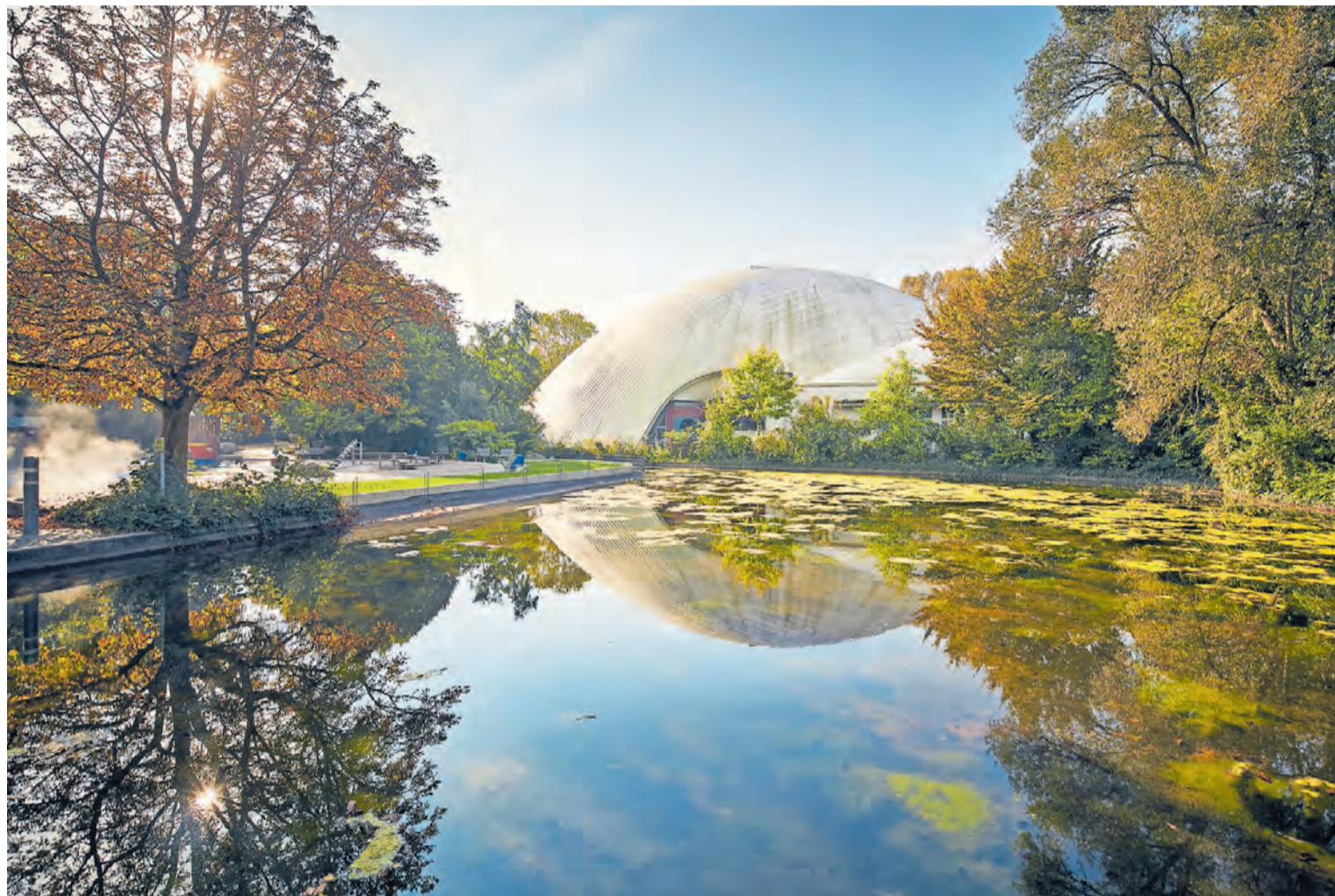
Die Sanierung soll plangemäß bis zum Start der Bundesgartenschau im Jahr 2023 ausgeführt werden.
