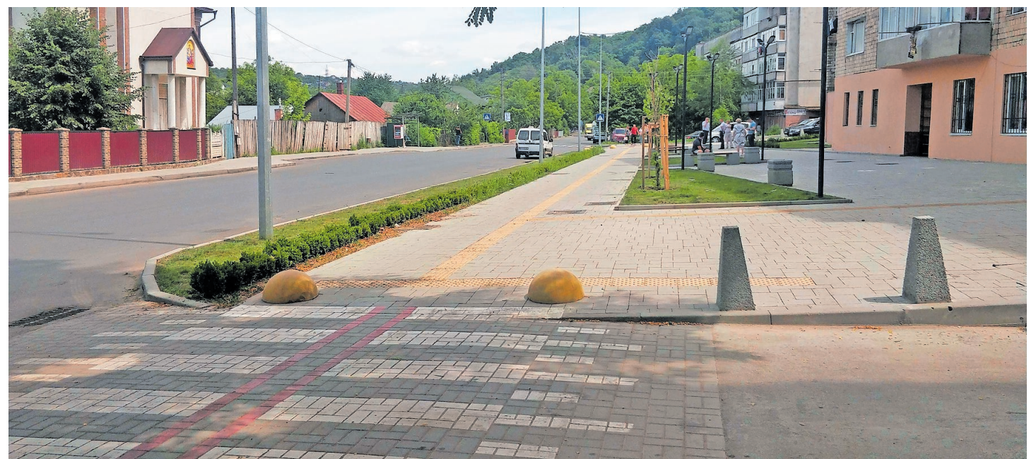
Der neugestaltete Platz ist heute völlig barrierefrei gestaltet und bietet eine hohe Aufenthaltsqualität.
