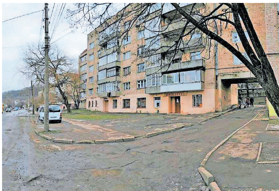
Der Platz Kalichanka vor den Umbaumaßnahmen.
