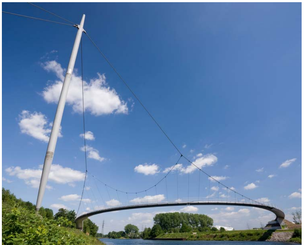
Schlauch Bergemann - Fuß- und Radwegbrücke Hafen Grimberg, Gelsenkirchen
