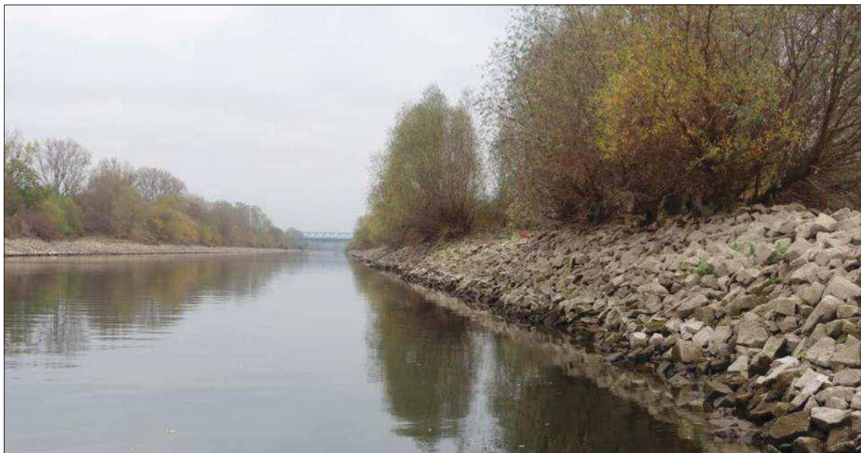
Abb. 11: Blick auf die bewachsene Uferböschung, welche durch das Biotop-Nr. 165172229020 eingenommen wird (rechts).
