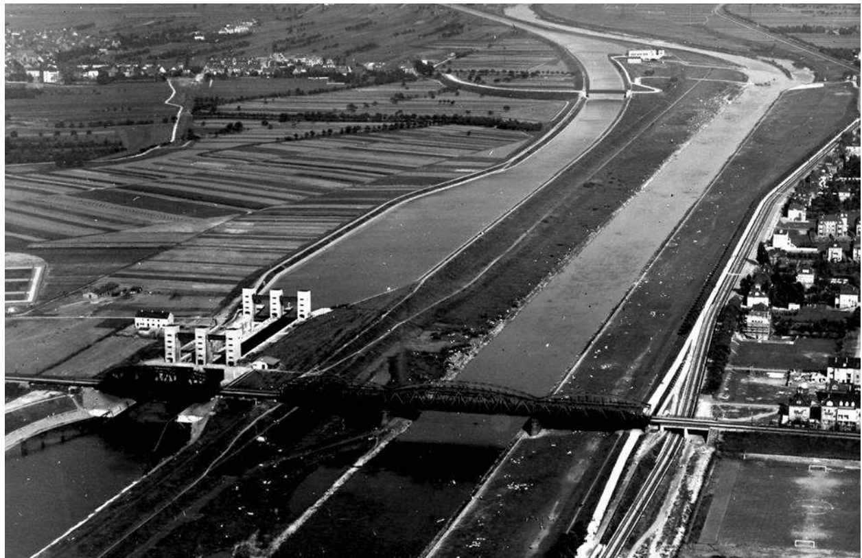
Abbildung 6: Luftbild des östlichen Projektgebietes nach Fertigstellung der Schleuse Feudenheim, ca. 1930 [Quelle: WSV, IZW-Medianarchiv]
