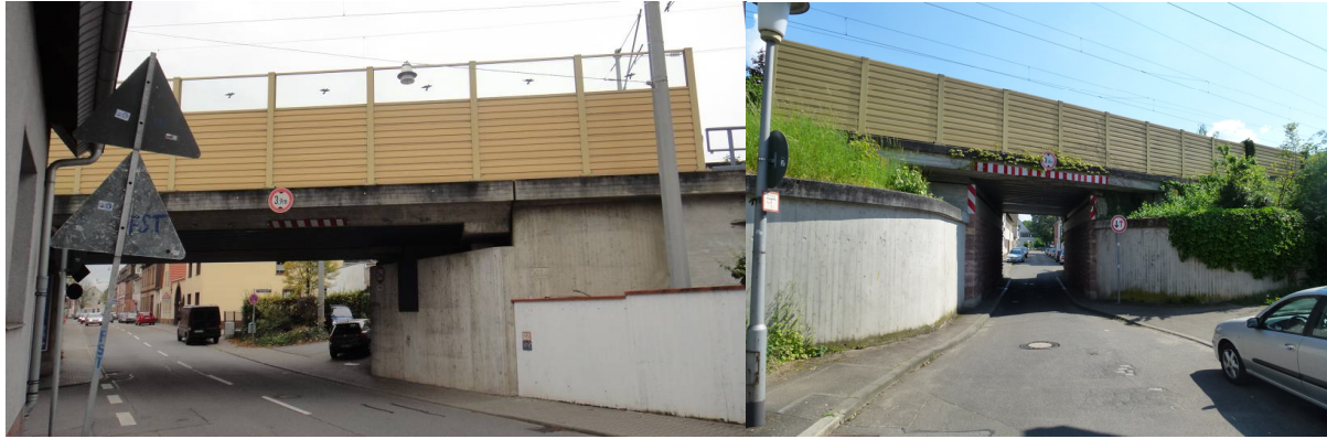
Abbildung 40: Südliche Zufahrt mit verengtem Straßenquerschnitt in der Vogesenstraße (li.), enge Durchfahrt in der Molsheimer Straße (Quelle: Fotodokumentation)
