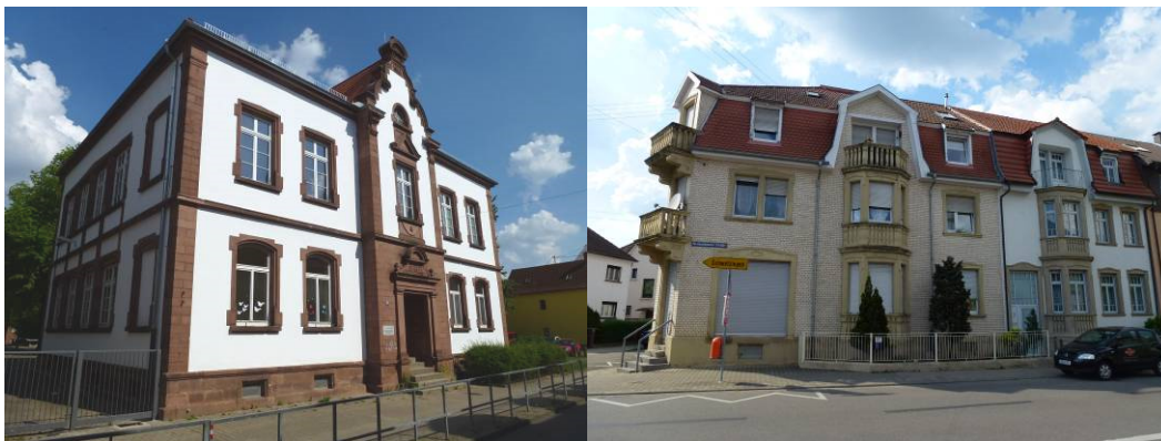
Abbildung 25: Denkmalgeschütztes altes Schulgebäude (li.), ortstypisches historisches Gebäudeensemble in der Neckarhauser Straße (Quelle: Fotodokumentation)
