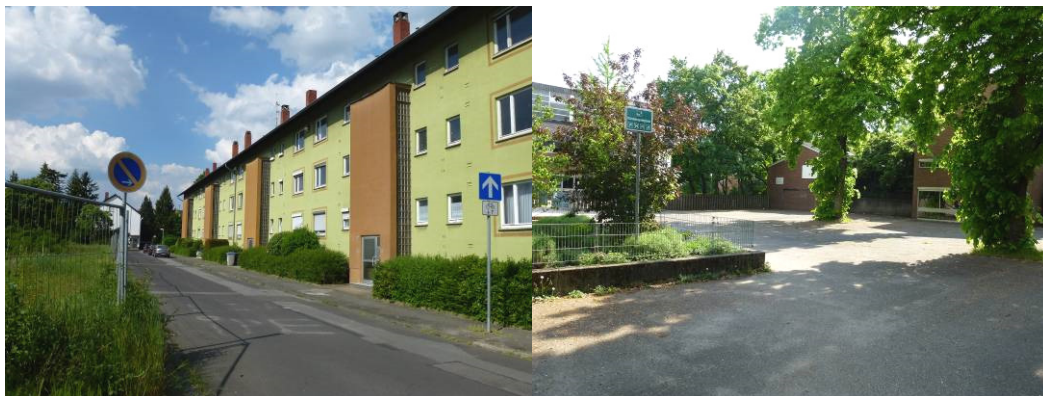
Abbildung 7: Linkes Bild: Zeilenhausbebauung am Bischweilerring (am linken Rand die Brachfläche des bereits abgerissenen Gebäudes); rechtes Bild: nördliches Gelände der Friedrichsfeldschule (Quelle: Fotodokumentation)
