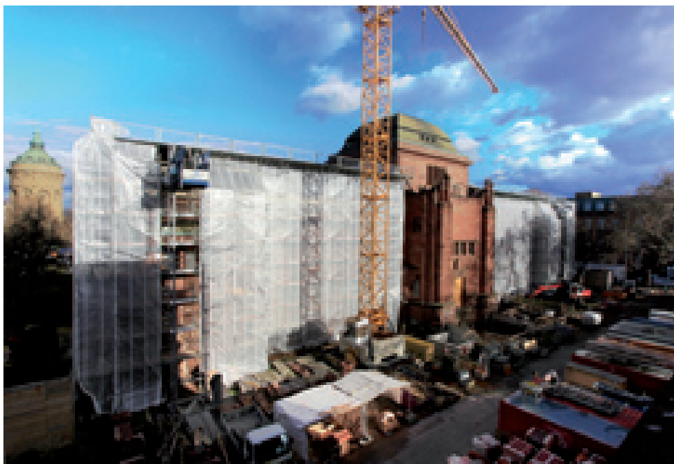
^ Die 2010 begonnenen Sanierungsmaßnahmen am und im Billing-Bau wurden 2011 fortgeführt. Foto: Cem Yüçetas
